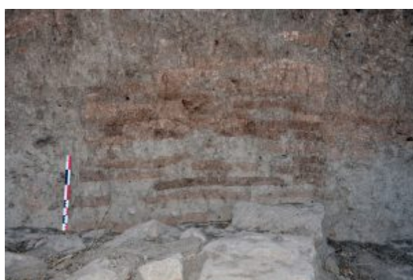
Superstructure d'un mur en terre massive
